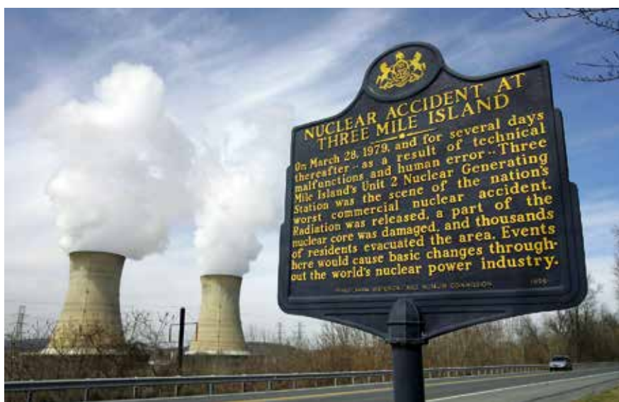
После аварии в Три-Майл-Айленде до 40 % стоимости АЭС в США составляют системы безопасности
