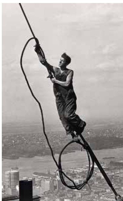
Раньше высотными работами занимались строители без верхолазного снаряжения
